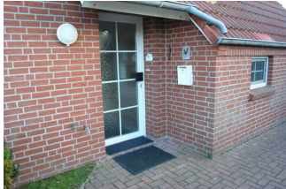
Weg außen auf dem Parkplatz und zum Eingang
