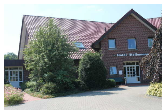
Haupteingang Hotel und zusätzliche Fläche zum Ein-/ Aussteigen und Entladen
