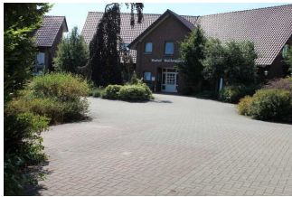
Weg vom Parkplatz zum Hoteleingang
