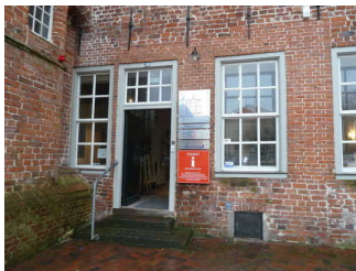
Stufen vor dem Haupteingang
