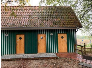
Öffentliches WC im Heidedorf (gegenüber Gebäude H1)
