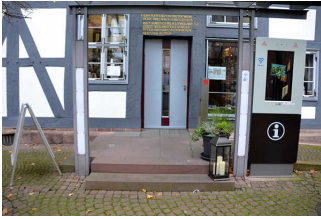
Stufen vor Eingang
