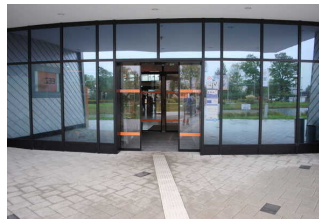
Tür im Eingangsbereich mit Windfang zu einer weiteren Tür
