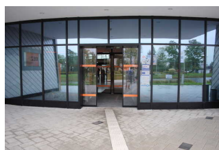
Tür im Eingangsbereich mit Windfang zu einer weiteren Tür
