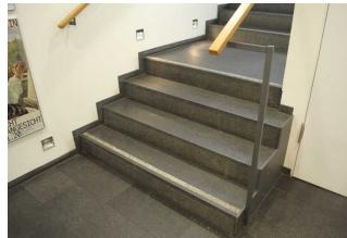
Treppe zwischen Foyer und UG zum WC für Menschen mit Behinderung
