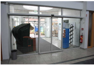
Windfang im Eingang in die "Kogge"
