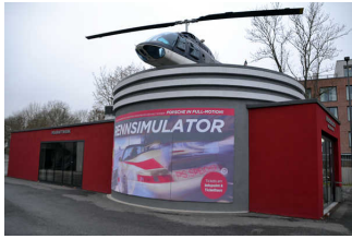
Rennsimulator-Gebäude im Außengelände
