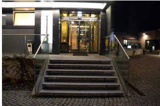
Außentreppe vor Vordereingang
