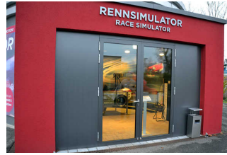
Rennsimulator-Gebäude im Außengelände
