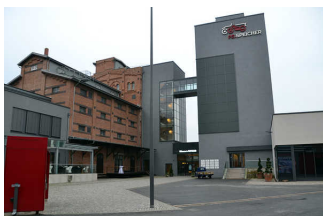
Weg vom Einlass zum Eingang
