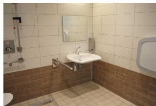
Dusche und WC für Menschen mit Behinderung zum Bad und den Spa-Bereich
