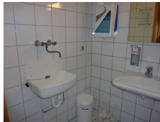
Barrierefreies WC, hier Waschbecken
