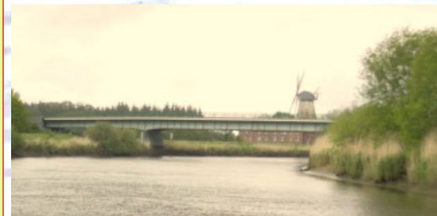
Straßenbrücke Hechthausen, Durchfahrtshöhe bei MTHw. 4,9 m
