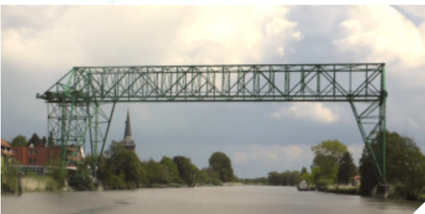
historische Schwebefähre Osten, Durchfahrtshöhe bei MTHw. 24 m
